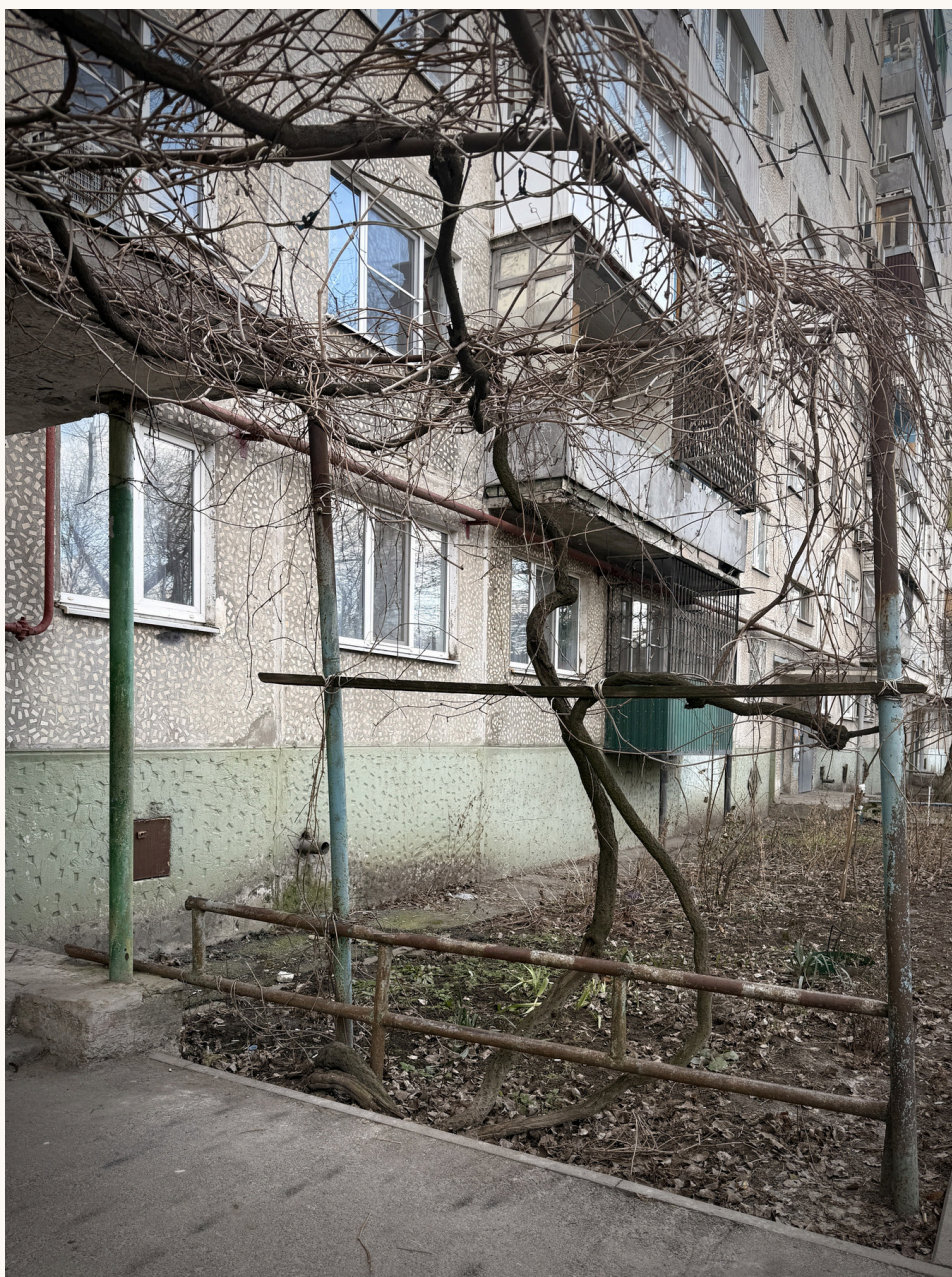
ФАСАД СО СТОРОНЫ ПОДЪЕЗДОВ Девятиэтажный жилой дом
